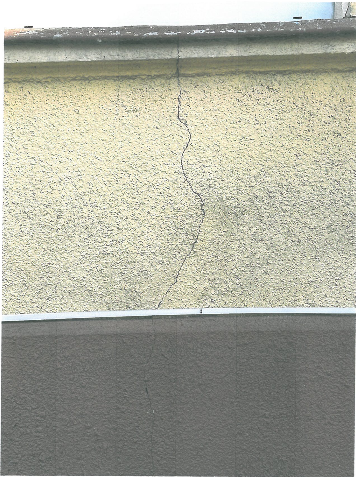
Fot. Nr4 Elewacja południowa budynku- widoczne spękania w ścianie.
