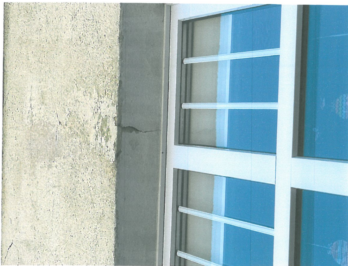
Nr10 Widok spękanej ściany – spód nadproża.
