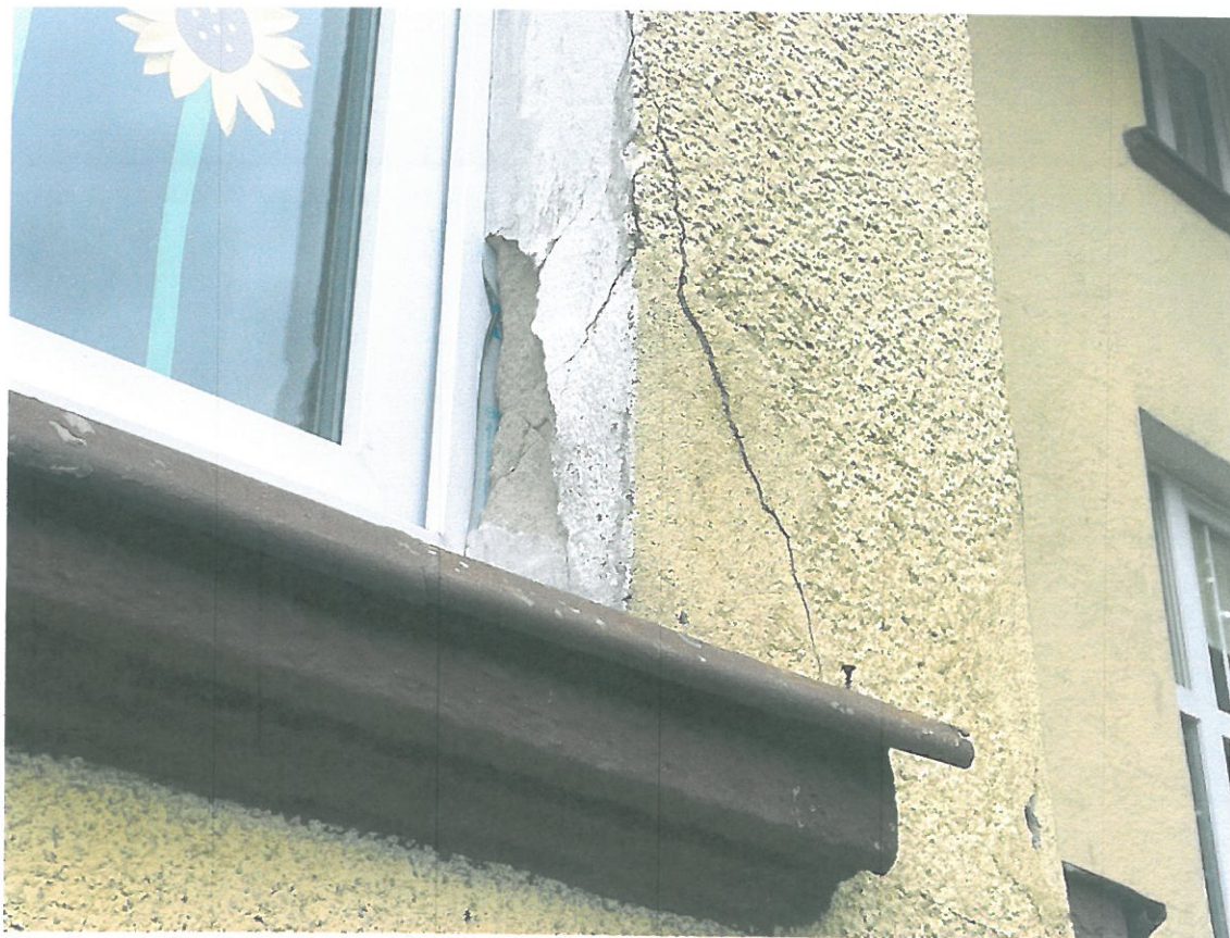
Fot. Nr8 Widok spękanej ściany oraz odparzonego tynku od strony zachodniej.
