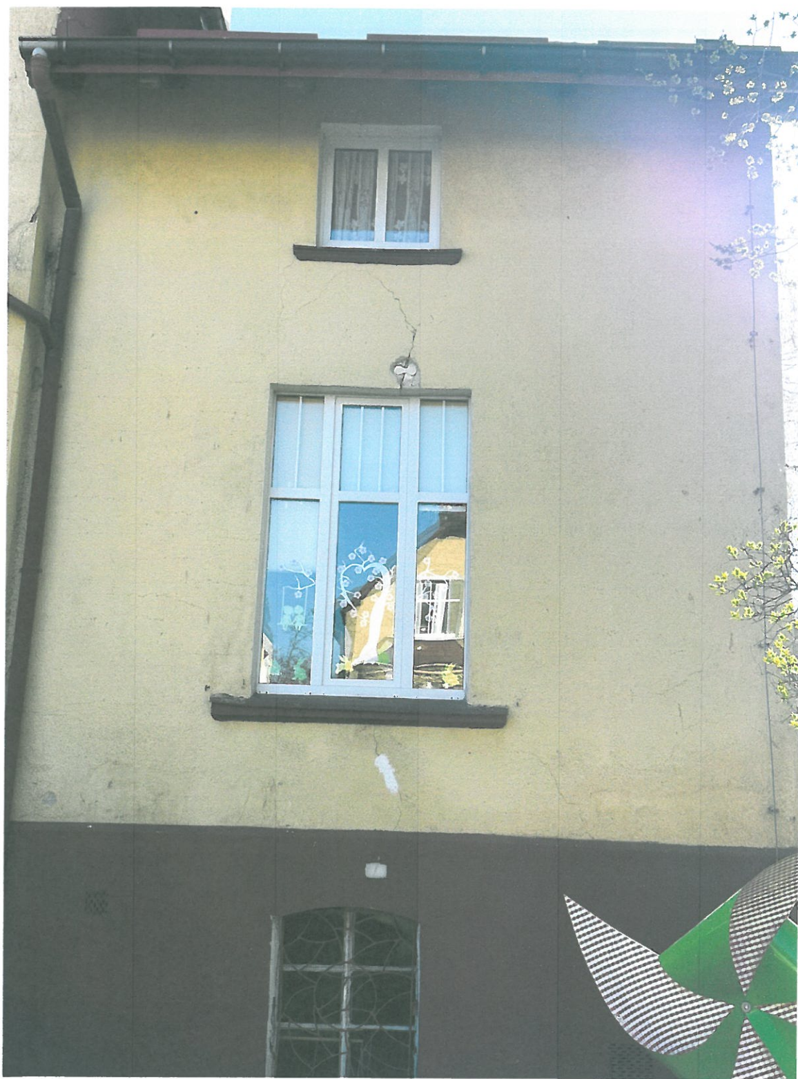
Fot. Nr2 Elewacja zachodnia budynku- widoczne spękania w ścianie.
