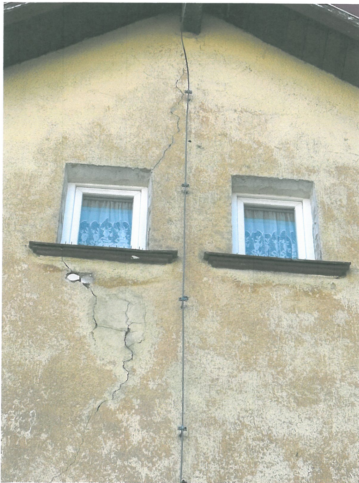
Fot. Nr3 Elewacja zachodnia budynku- widoczne spękania w ścianie.
