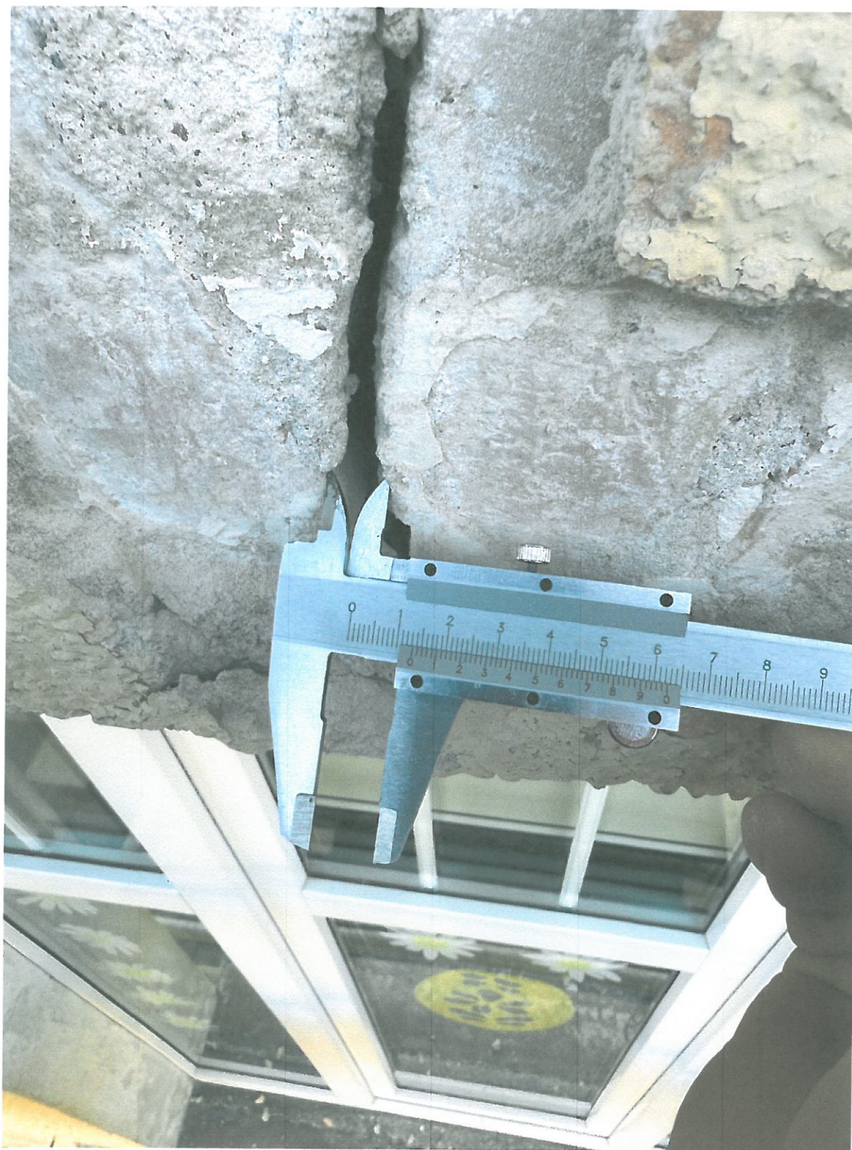
Fot. Nr5 Fotografia przedstawiająca uszkodzenie warstwy osłonowej muru po usunięciu tynku – szczelina między cegłami około 13mm.
