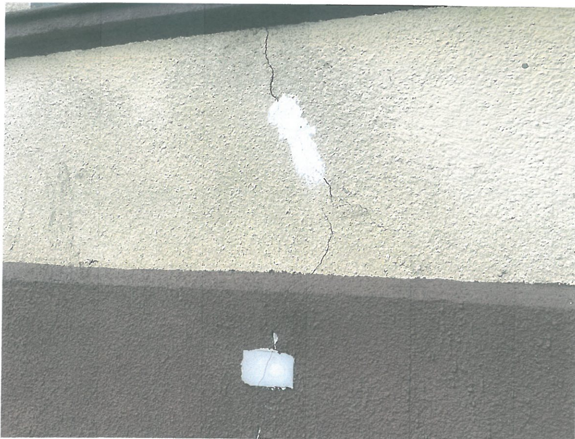
Nr9 Widok spękanej ściany na styku kondygnacji piwnicy i parteru.
