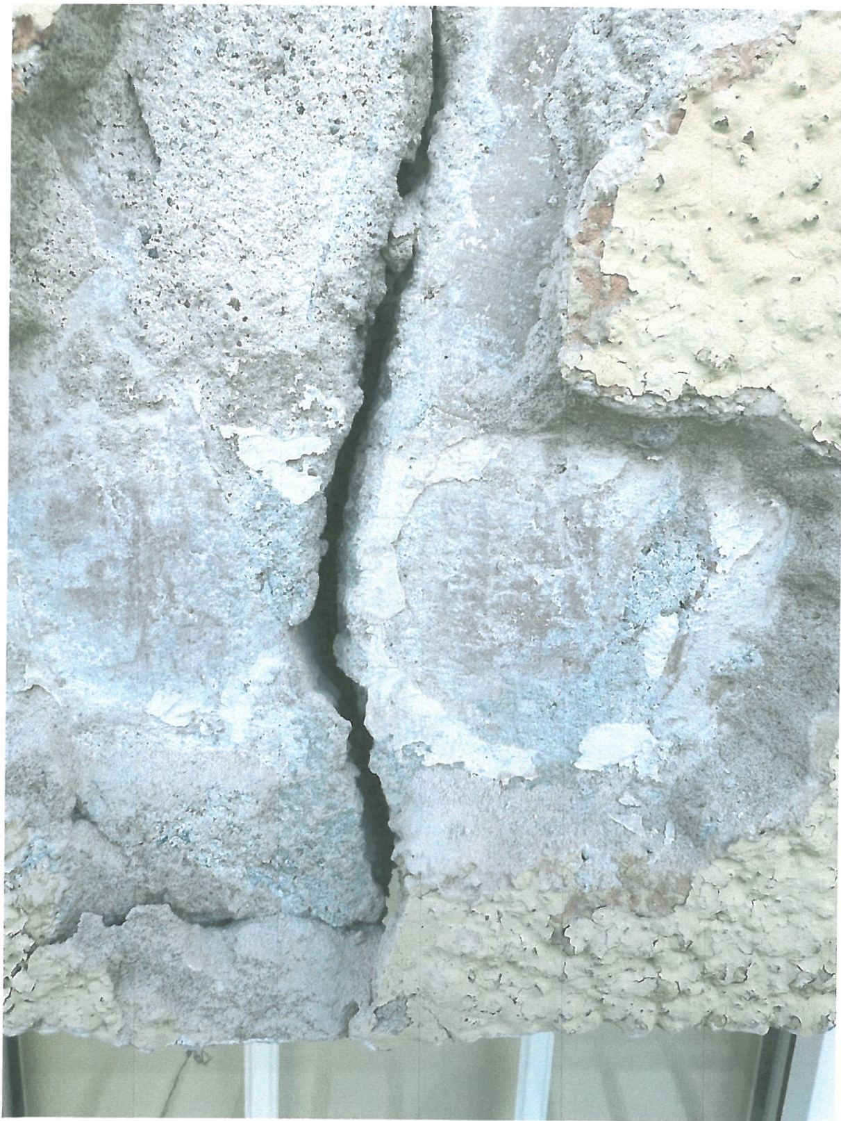
Fot. Nr6 Widok spękanej ściany po usunięciu tynku..
