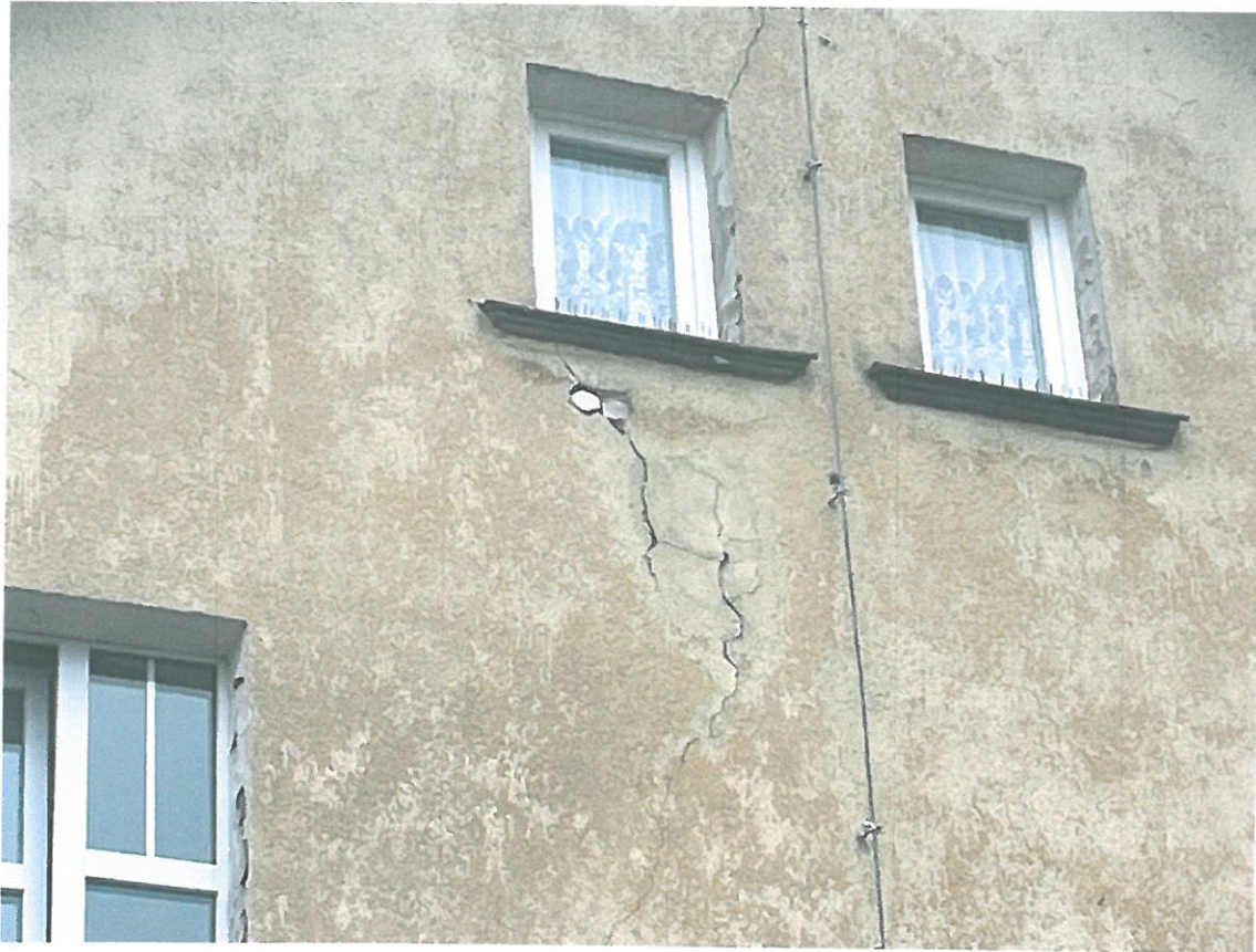
Fot. Nr7 Widok spękanej ściany od strony zachodniej.
