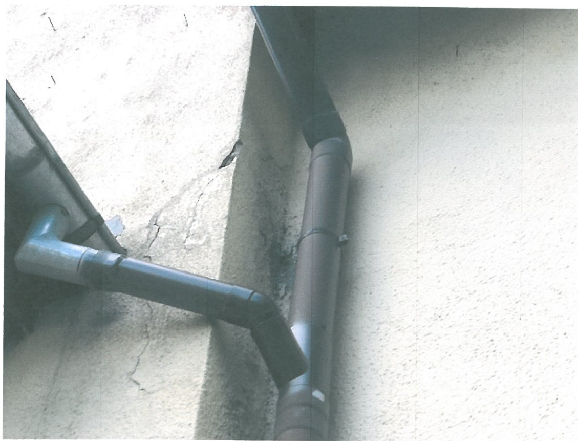
Nr12 Widok spękanej ściany.
